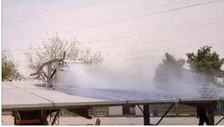
चित्र: एनटीपीसी भड़ला में धूल सफाई प्रणाली का प्रदर्शन।
